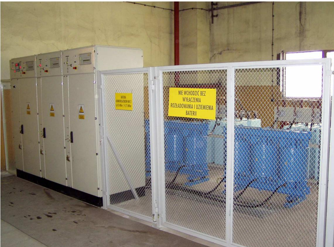
Батареи типа BSWD с регуляционными и питательными полями (батареи типа ACRD...z)
