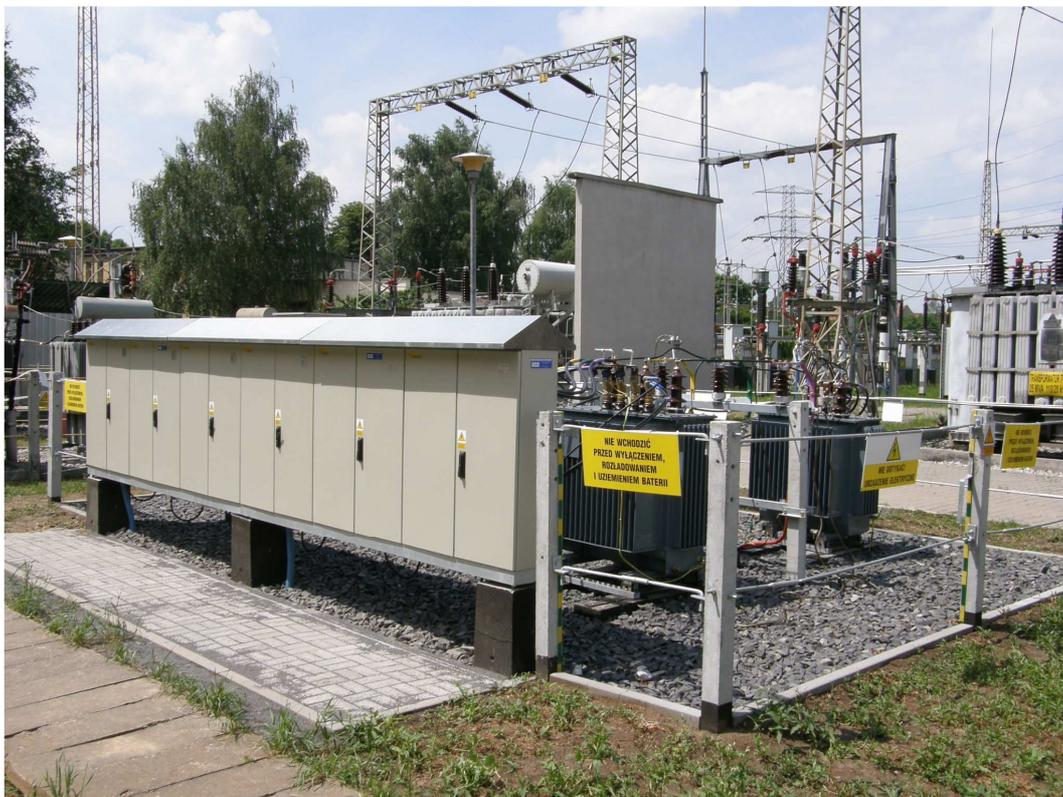
Наружный трансформаторный фильтр 20кВ со стыковыми контакторами
