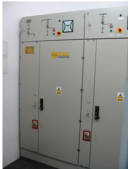
Регуляционные и питательные поля батарей с полями конденсаторов в конструкциях типа ACR...z, ACRD...z
