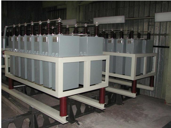
Батареи конденсаторов среднего напряжения 30...72кВ обычно проектируется для индивидуальной компенсации в системе фильтров высших гармоник. Они могут быть использованы как устройства индивидуальной компенсации, автоматически управляемые устройства (включаемые с помощью вакуумных выключателей) или батареи FC системы компенсации следящей SBC.
