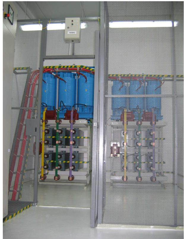
Батареи типа BSWD с регуляционными и питательными полями (батареи типа ACRD...z)
